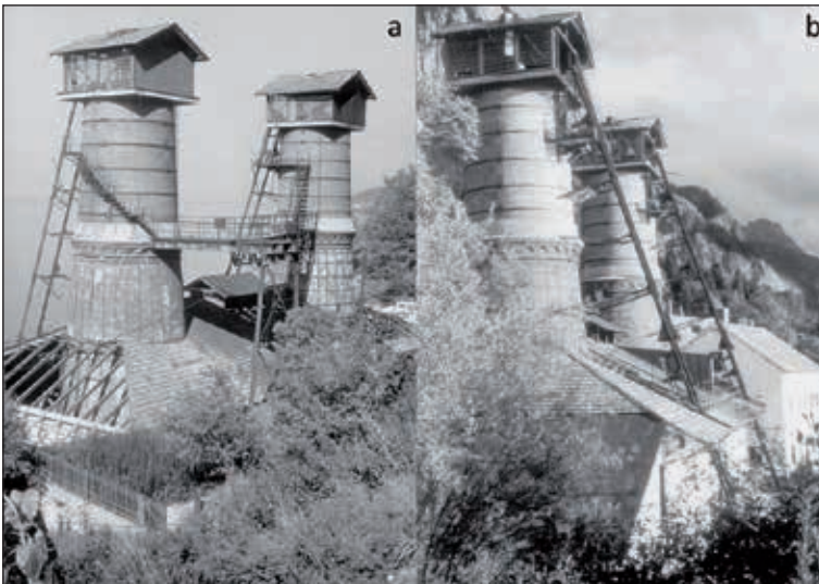
Abb. 11: Die beiden Hinteren Brennöfen der Staininger Kalkwerke mit Blick Richtung Nordwesten (a) bzw. nach Südosten (b) kurz vor ihrer Sprengung im Jahre 1971. Gut zu erkennen sind auch die Führungen der Kalkaufzüge die 1932 in Betrieb genommen wurden.
